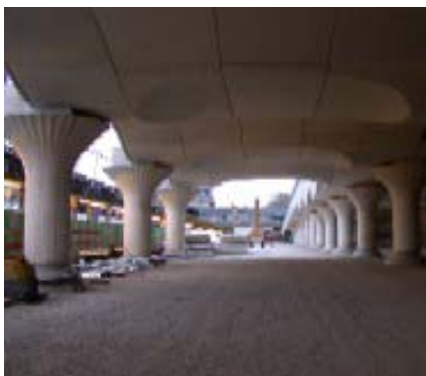
▲ Extension de la couverture
